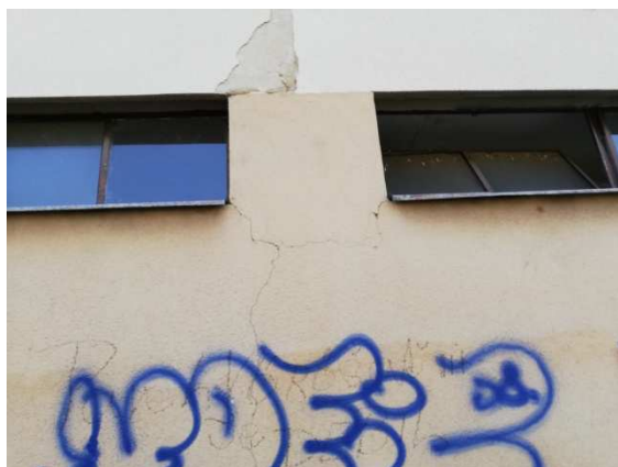
25. Stav omítek západní fasády z trhlinami ve zdivu
