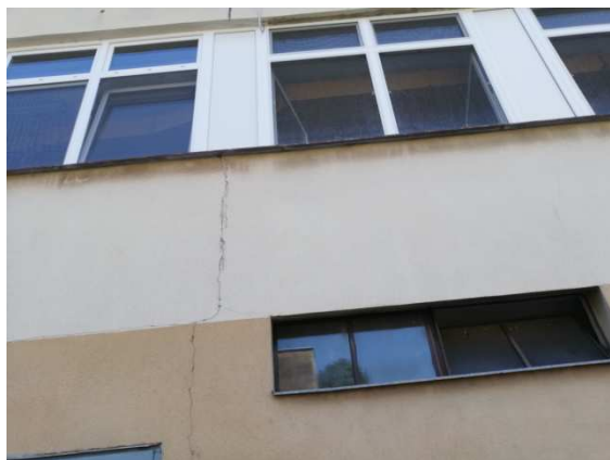
26. svislá trhlina v
