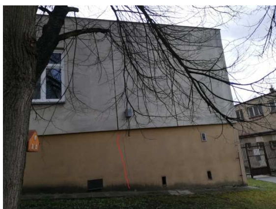
9. severní fasáda s trhlinou zdiva 1.PP
