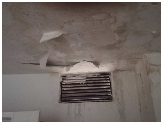
42. Mapy zatékání na stropě v 1.PP
