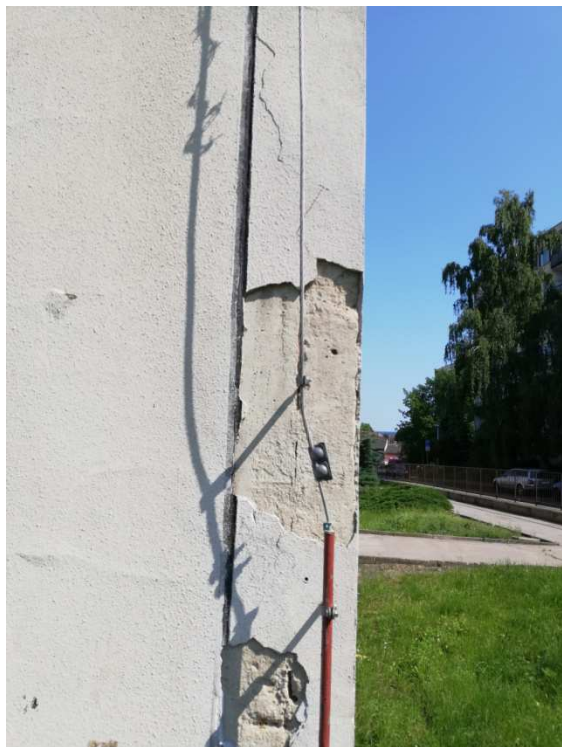
19. poškození čela stěnového panelu
