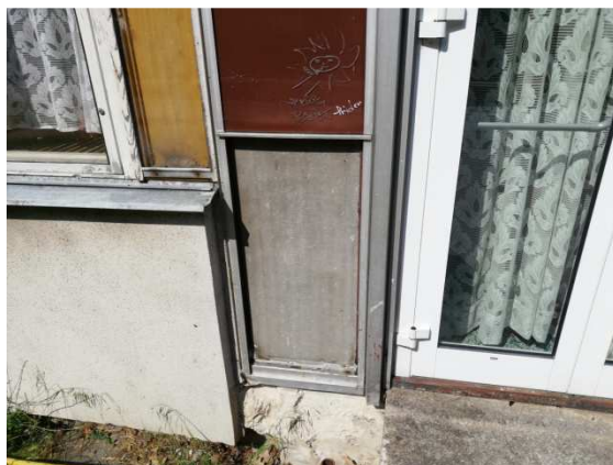
17. detail chybějícího krycího skla s obnaženou azbestocementovou deskou
