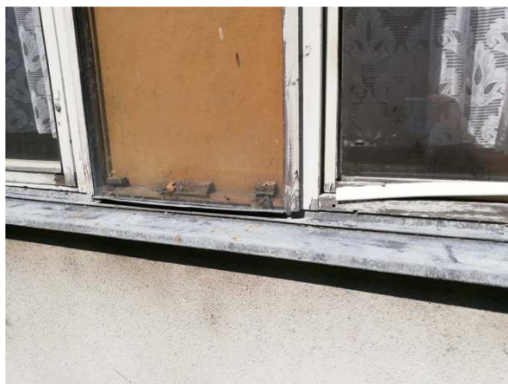
15. detail stavu meziokenních vložek východní fasády
