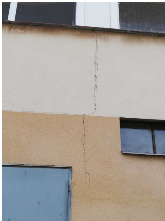
24a . trhlina v západní fasádě 1.PP
