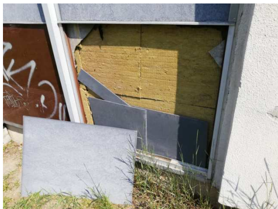
21. pohled na skladbu LOP bez krycí desky z opakního skla a azbestocementové desky
