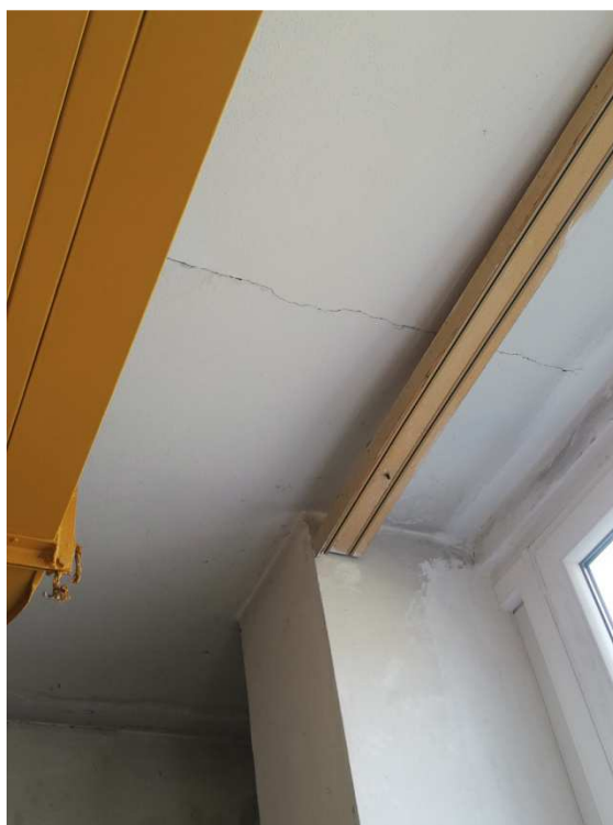
43. Mapy zatékání na stropě pod jihozápadním nárožím v 1.NP
