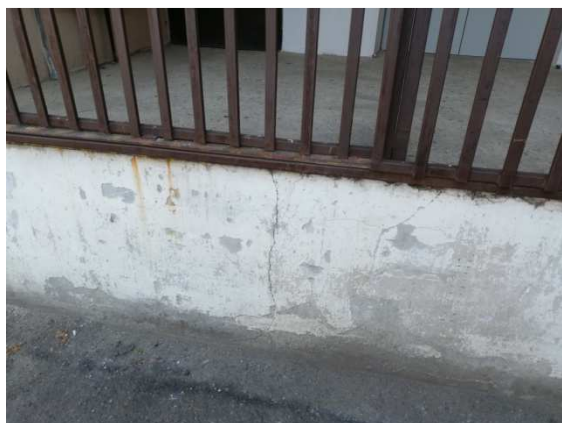
29. svislá trhlina v soklu rampy
