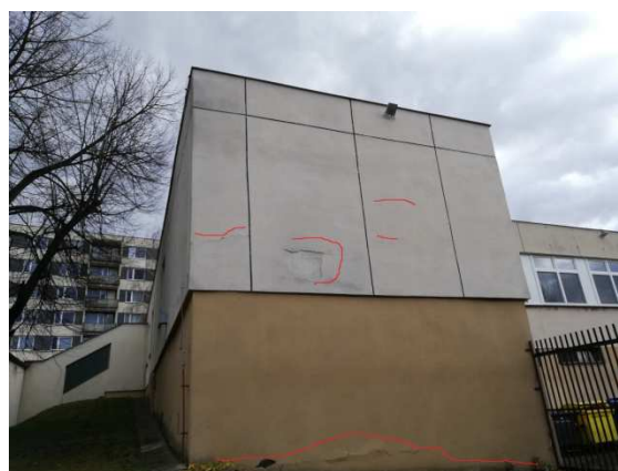
12. detail poruch omítek západní fasády přístavby
