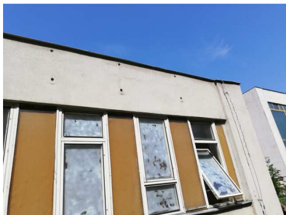
14. stav meziokenních vložek východní fasády
