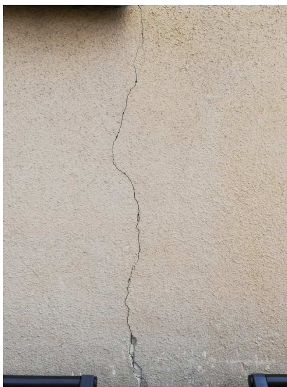
27a. detail trhliny v západní fasádě 1.PP
