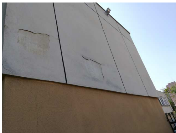
13. detail poruch omítek západní fasády přístavby
